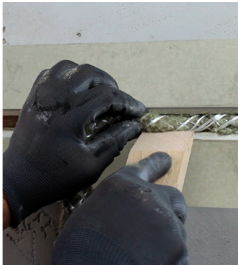
Nullifire FJ203 in Fuge einbringen
