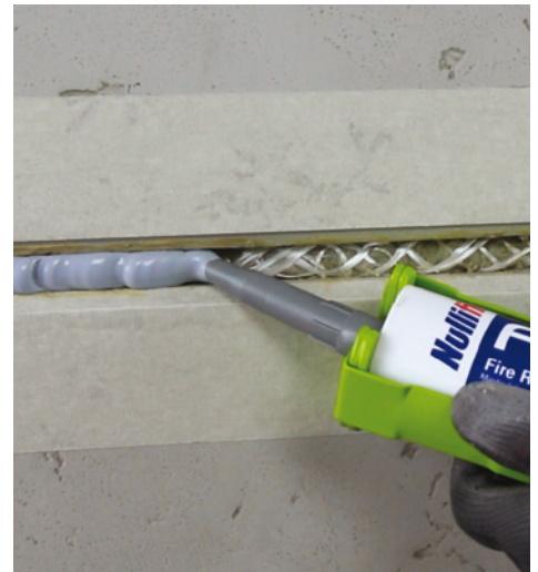
Fuge kann anschließend je nach Wunsch mit einem geeigneten Dichtstoff (z. B. Nullifire FS702, FS703 oder illbruck SP525) versiegelt werden
