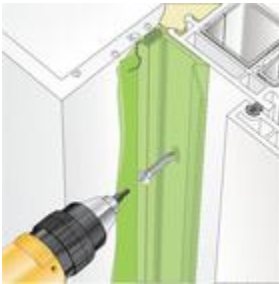
Bild 2: Befestigung mit geeigneten Schrauben.
