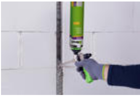
Verarbeitung mit FM190 in einer Brandschutzwand.
