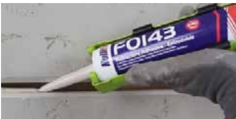
Exemple d'utilisation de la colle FO143 avec le bourrelet FJ203 Altofeu et le silicone FS703.
