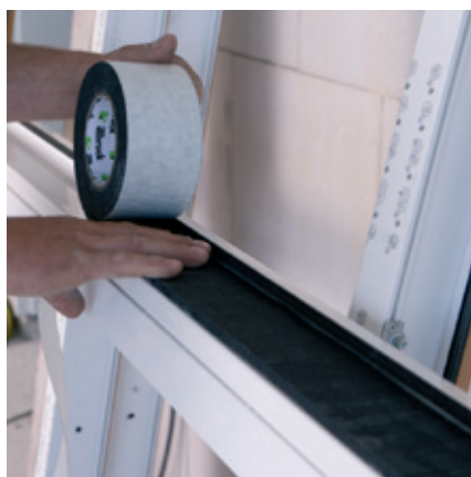
Aplikace TP652 na rám okna. Jednoduše, rychle a čistě.
